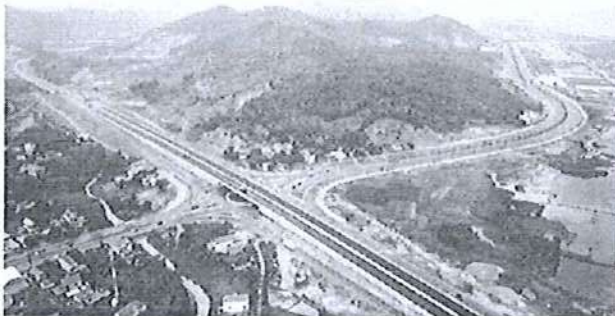
Cao tốc Hạ Long – Vân Đồn: Thi công Km36+00 đến Km43+00
